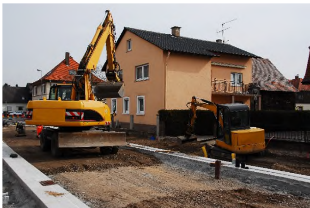
Straßenbauarbeiten in einem Neubaugebiet H.D.Volz / pixelio.de
